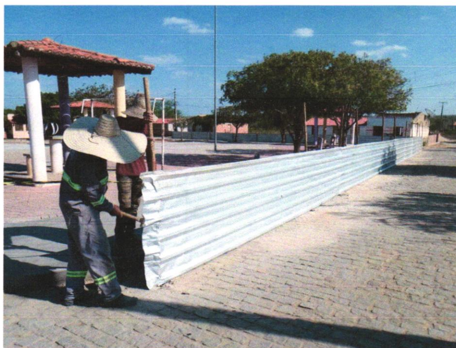
Foto 01 - TAPUME COM TELHA METÁLICA. AF_05/2018
