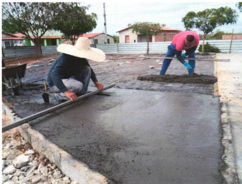
Foto 05 - PAVIMENTAÇÃO EM CONCRETO, COM ESPESSURA DE 7 CM, COM ACABAMENTO FEITO UTILIZANDO ALISADORA DE CONCRETO (HELICOPTERO), INCLUIDO TELA DE AÇO SOLDADA NERVURADA CA60, Q196 (3,11 KG/M2), DIAMETRO DO FIO 5.0 MM, LARGURA = 2,45 M, ESPAÇAMENTO DA MALHA = 10 X 10 CM, JUNTA DE DILATAÇÃO EM PVC A CADA 2,00 M, CONCRETO FCK = 20 MPA
