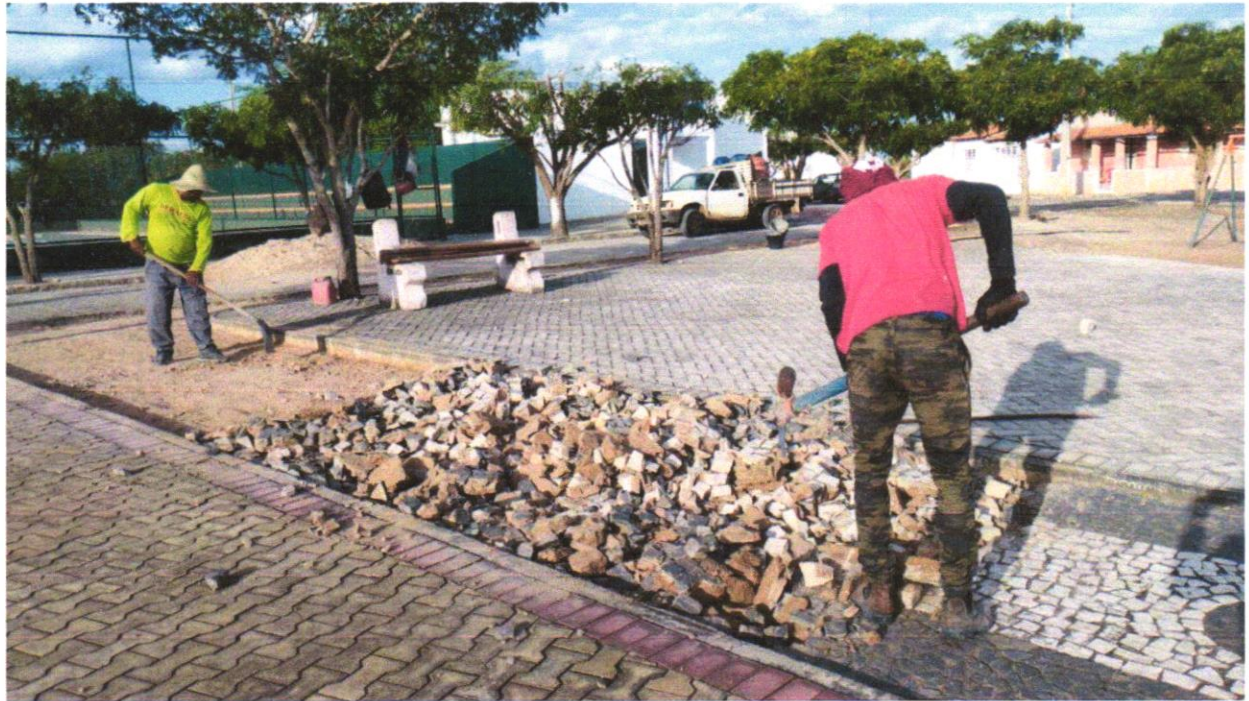
Foto 07 - Remoção de piso em Pedra Portuguesa
