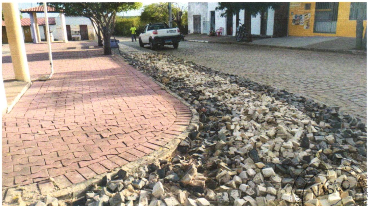
Foto 08 - Remoção de piso em Pedra Portuguesa
