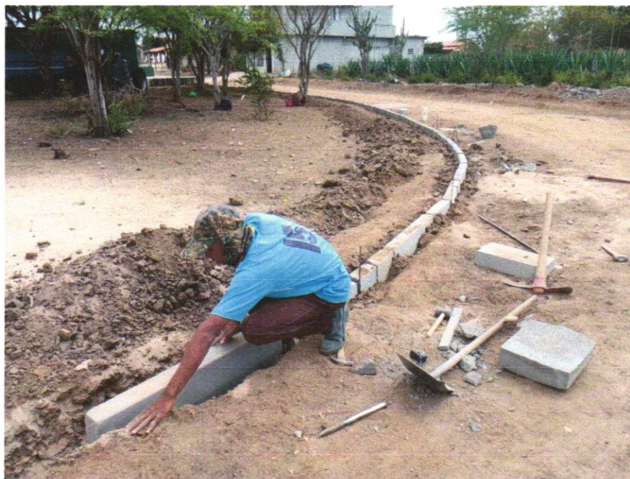
Foto 03- ASSENTAMENTO DE GUIA (MEIO-FIO) EM TRECHO RETO, CONFECCIONADA EM CONCRETO PRÉ-FABRICADO, DIMENSÕES 100X15X13X20 CM (COMPRIMENTO X BASE INFERIOR X BASE SUPERIOR X ALTURA), PARA URBANIZAÇÃO INTERNA DE EMPREENDIMENTOS. AF_06/2016_P
